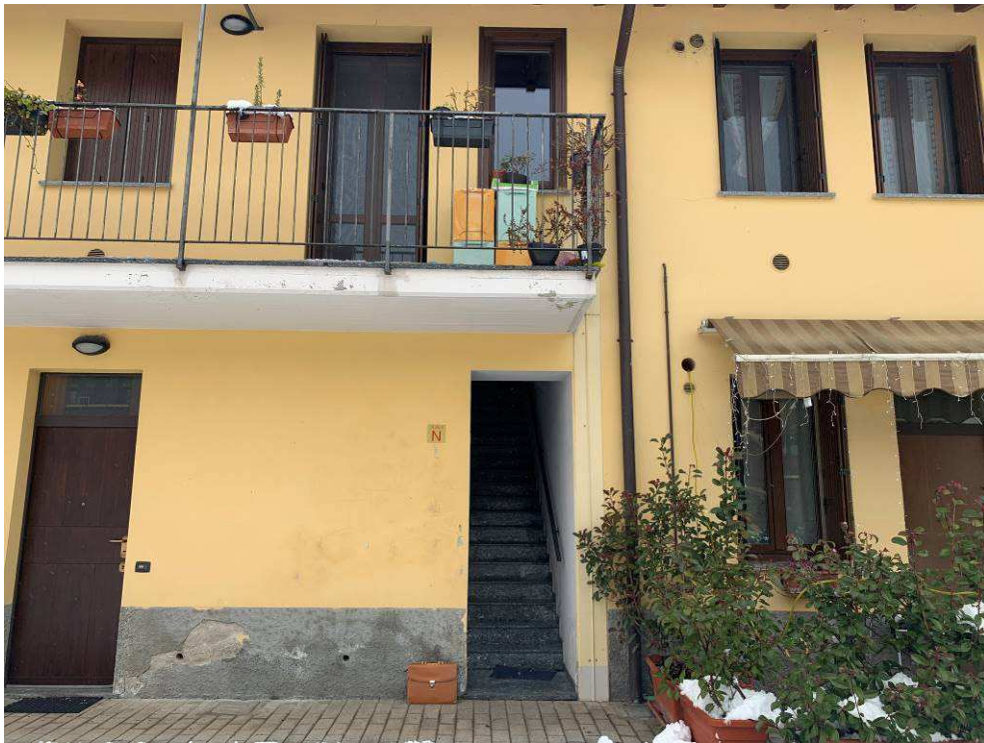
Fotografia n. 10 – Vista dell'ingresso all'immobile staggito con balcone (scala N), posto al piano primo e accessibile per mezzo di scala
